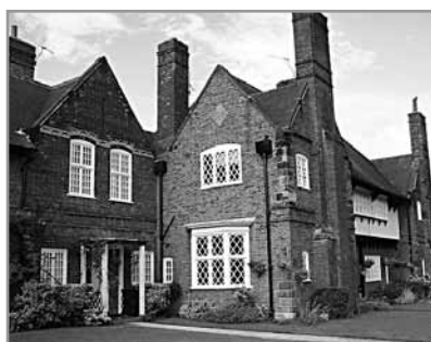
Ryc. 134. Port Sunlight – zabudowa mieszkaniowa.
