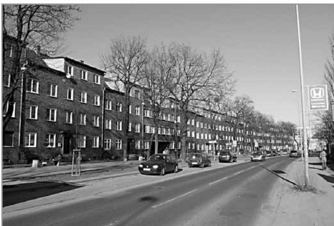
Ryc. 170. Gdańsk-Wrzeszcz, ul. Kościuszki, współczesna modernistyczna zabudowa mieszkaniowa zrealizowana na podstawie planu H. Althoffa.
