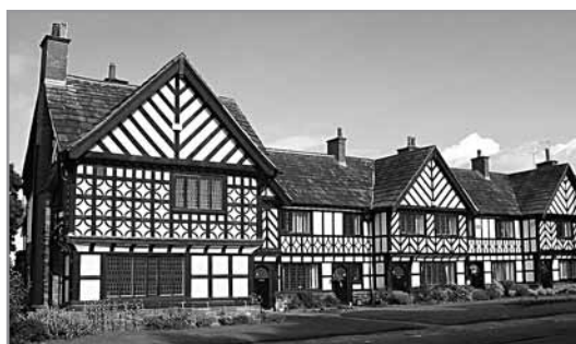
Ryc. 133. Port Sunlight – zabudowa mieszkaniowa.
