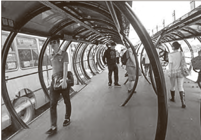
Ryc. 24. Kurtyba. Linie autobusowe różnią się kolorami; przystanki mają udogodnienia przesiadkowe (fot. Aleksandra Sas-Bojarska).
