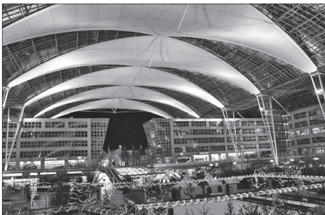
Przedsięwzięcia urbanistyczne dużej skali realizowane na nowych obszarach rozwojowych miasta: Parc de La Vilette, Paryż, Francja (ryc. 23 i 24), nowy kompleks terminala lotniczego w Monachium, Niemcy (ryc. 25).
