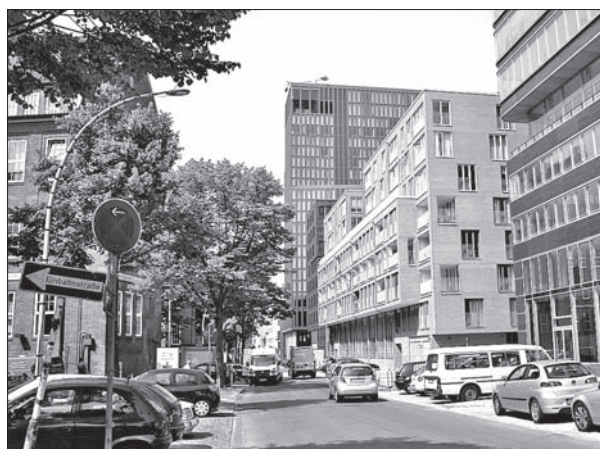
Przedsięwzięcia urbanistyczne dużej skali realizowane na terenach opuszczonych przez dotychczasowych użytkowników; zabudowa dawnego browaru Bavaria, Hamburg, Niemcy (ryc. 34, 35, 36, 37).
