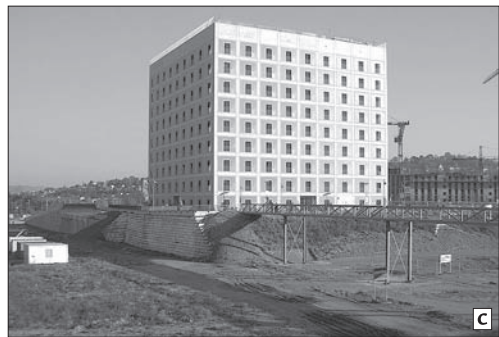
Ryc. 7. Obszar rozwojowy Europaviertel: (a) plan udostępnienia terenów, (b) wizualizacja zagospodarowania, (c) Biblioteka Miejska – widok z kamery rejestrującej postępy budowy, wrzesień 2011 – proj. Eun Young ( www.stuttgart.de ).
