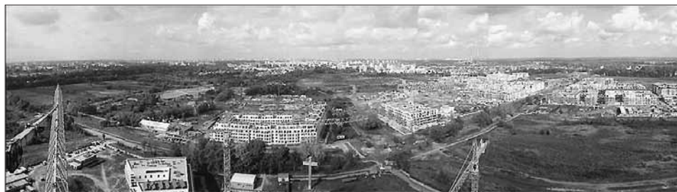
Ryc. 40. Miasteczko Wilanów w budowie. Zdjęcie wykonane z dźwigu na budowie Świątyni Opatrzności Bożej, 2008 rok (Archiwum firmy INVI).
