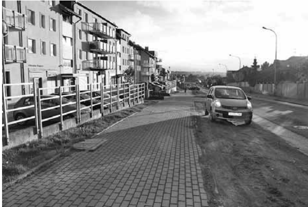
Ryc. 31. Wygodzona przestrzeń nowych, zamkniętych osiedli mieszkaniowych, brak dostępu do obiektów handlowo-usługowych i brak miejsc parkingowych zmusza kierowców do parkowania na wąskich pasach trawników, które szybko ulegają zniszczeniu. Gdańsk, ul. Myśliwska
