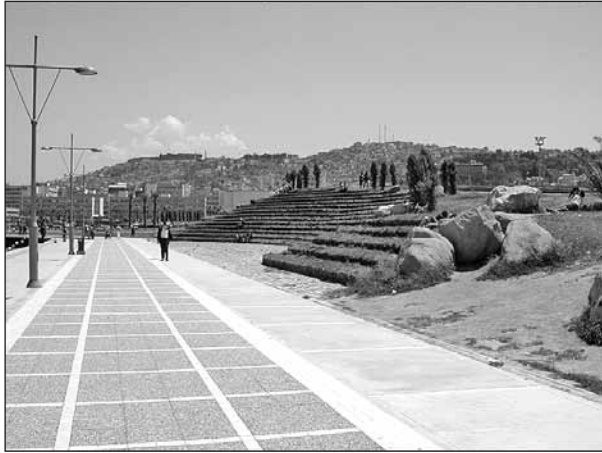
Ryc. 59. Skraj wiaduktu od strony morza.
