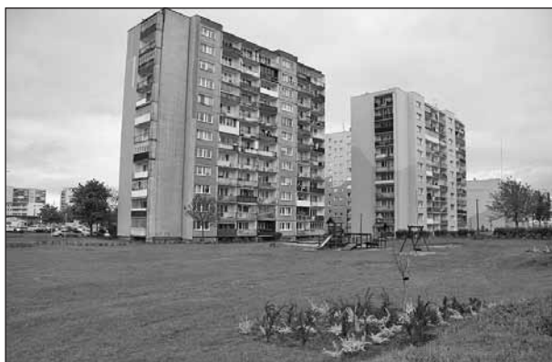
Ryc. 33. Osiedle Modre w Straszynie – zieleń ozdobna wewnątrz zamkniętego osiedla.
