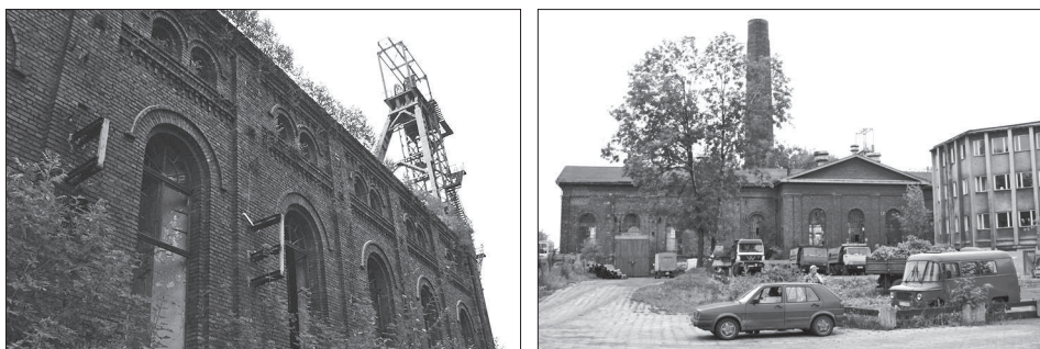
Ryc. 77. Budynek maszynowni i nadszybie (z lewej) oraz cechowni (z prawej) – stan z 2006 roku (fot. M. Stangel).
