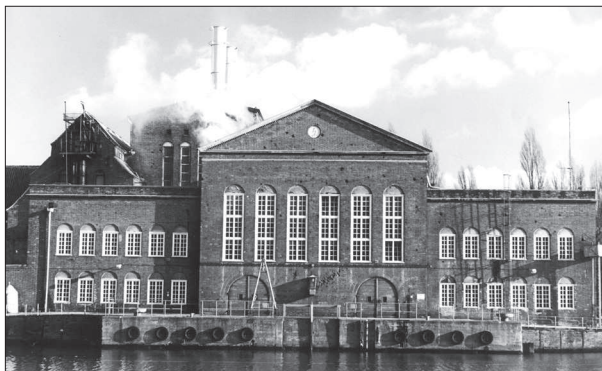
Ryc. 74. Wyspa Ołowianka w 1996 r. (u góry); elektrociepłownia widok od Motławy, stan z 1997 roku (u dołu) (fot. z materiałów Gdańskiej Filharmonii Bałtyckiej).
