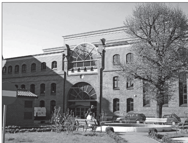
Ryc. 76. Gdańskie Centrum Muzyczno-Kongresowe. Elewacja południowa (u góry) oraz zachodnia (u dołu) – stan z 2005 roku (fot. D. Kamrowska-Zaluska).
