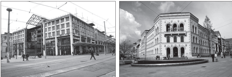
Ryc. 19. Przebudowywana Saar-Galerie w Saarbrücken (fot. S. Ledwoń).
