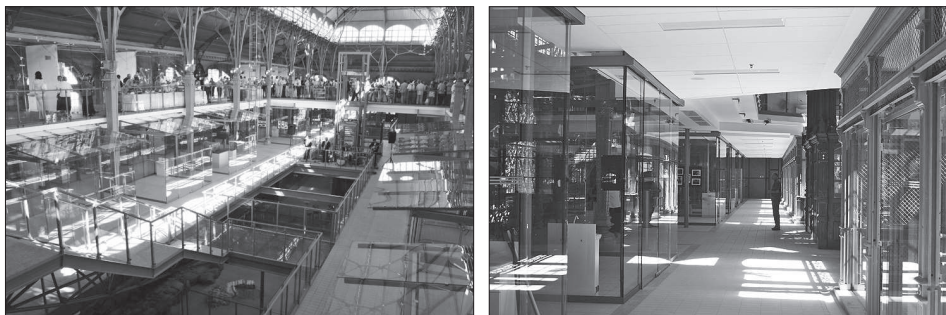
Ryc. 24. Modernizacja Hali Targowej w Gdańsku (fot. S. Ledwoń).
