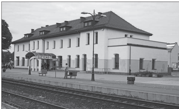
Ryc. 28. Dworzec w Giżycku po przebudowie, 2005–2006 (fot. D. Załuski).
