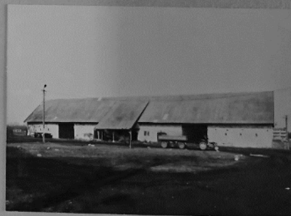
30. Stodoła II - elewacja frontowa /pd./
