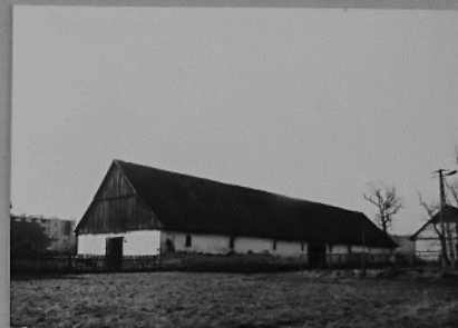
28. Owczarnia - elewacja tylna /pu./
