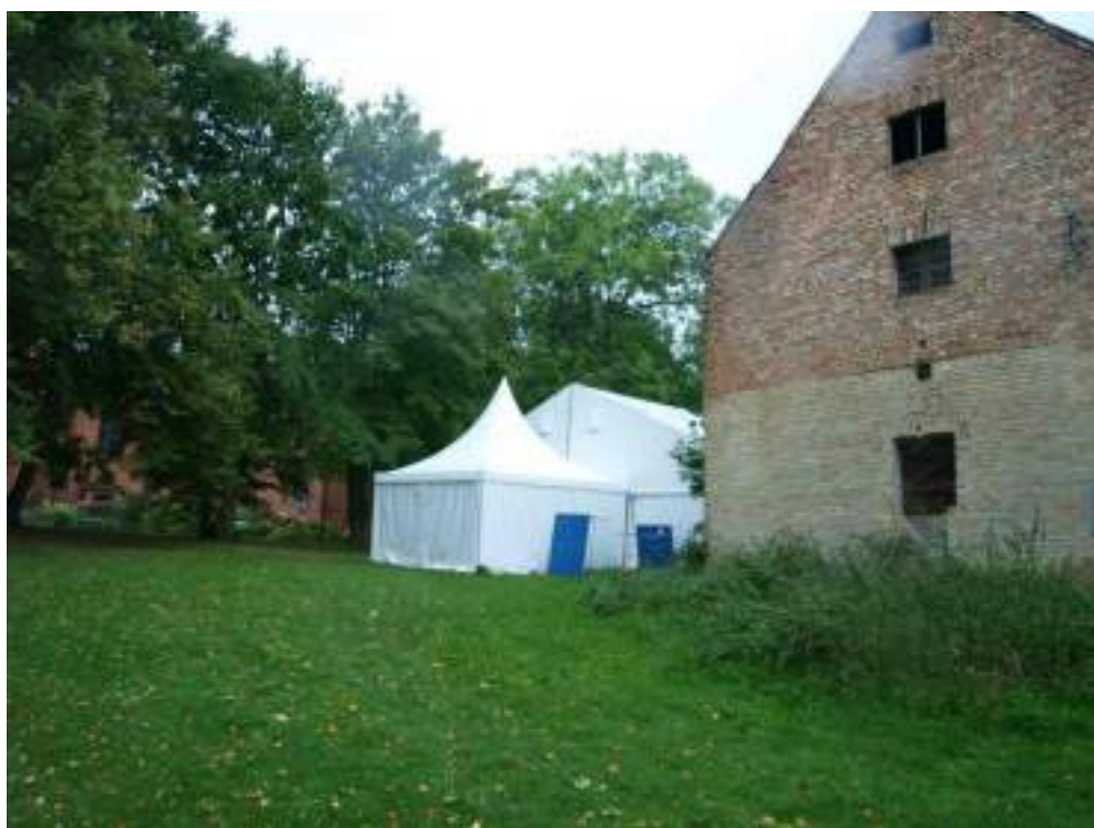
ryc. 27. Widok na namiot tymczasowy oraz fragment spichlerzu, źródło: własne zbiory
