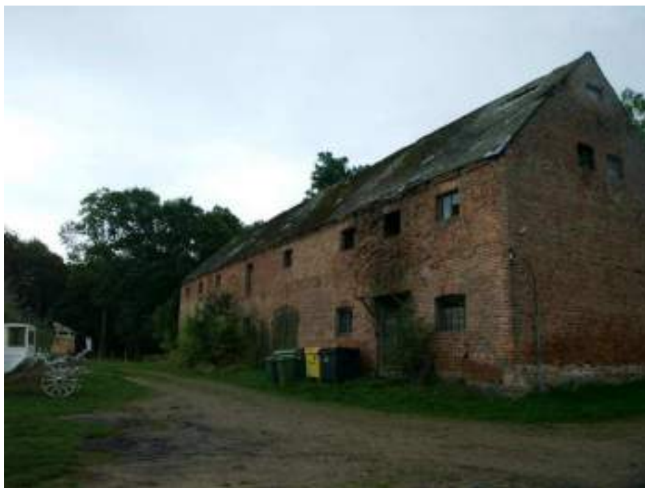
ryc. 35 Widok na spichlerz od strony wnętrza dziedzińca folwarku, źródło: własne zbiory
