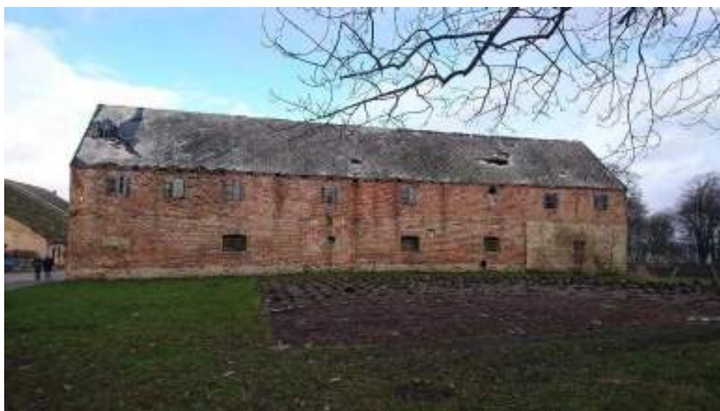
ryc. 36 Widok na spichlerz od strony zamku, źródło: własne zbiory
