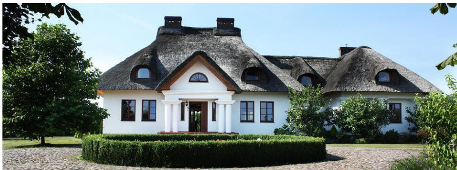
Zdj. 10. Widok na elewację frontową dworku w Łuskowie, Łuskowo 26a ( www.sprzedajemy.pl ).
