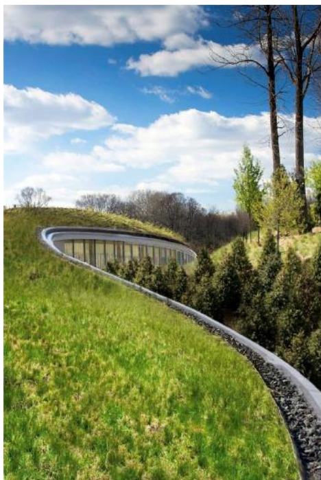
Zdj. 8. Widok na dach zielony (© Albert Večerka/Esto).
