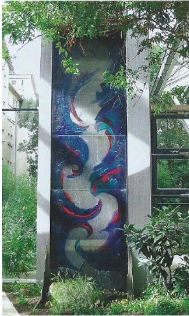
Zdj. 4. Ściana wodna wykonana z barwionego szkła wprowadzająca świeże powietrze o regulowanej temperaturze do przeszklonej części obiektu (C. J. Hoyer).
