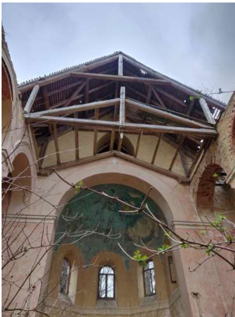
Fig. 39 Pozostałości więźby dachowej. (autor: S. Tarnowska)
