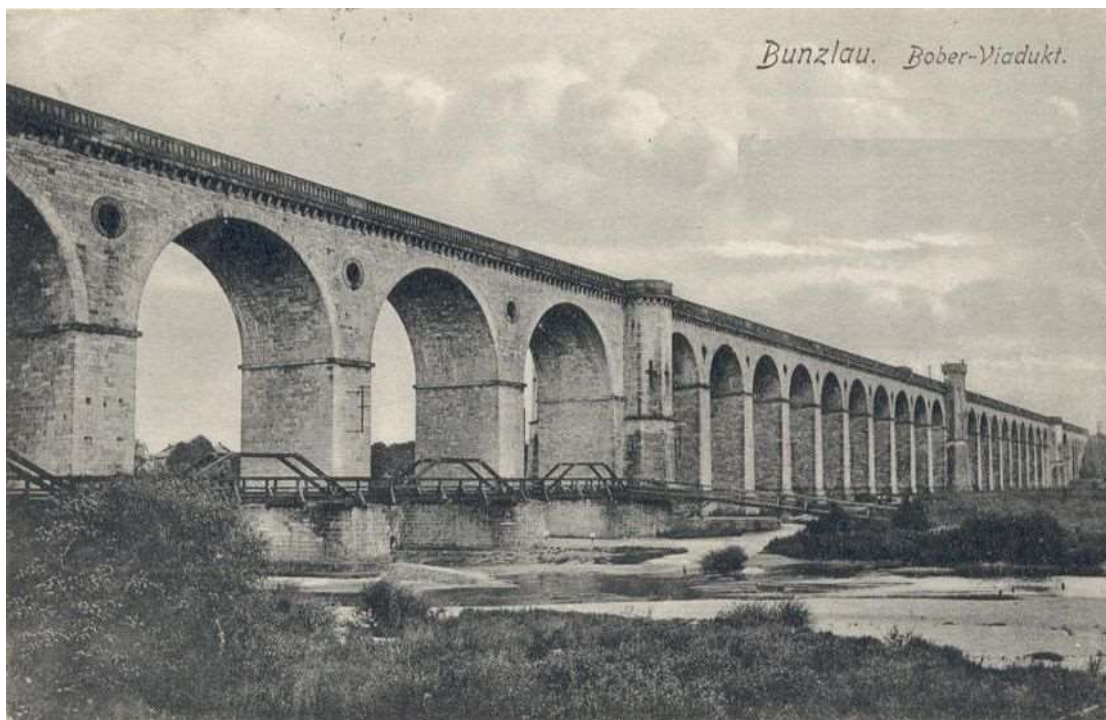
Fig. 19 Most kolejowy na rzece Bóbr w Bolesławcu projektu architekta Engelhardta Gansela. 1 poł. XX wieku. (zbiory portalu „Poloniae Amici polska-org.pl”)
