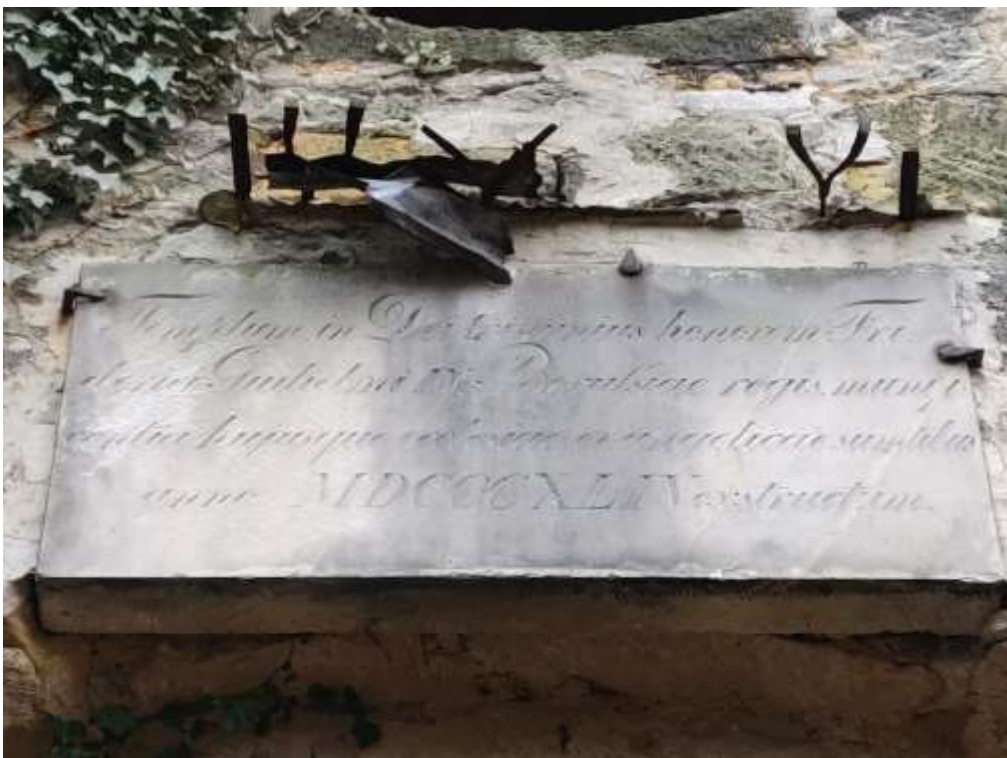
Fig. 35 Tablica nad wejściem do obiektu. (autor: S. Tarnowska)
