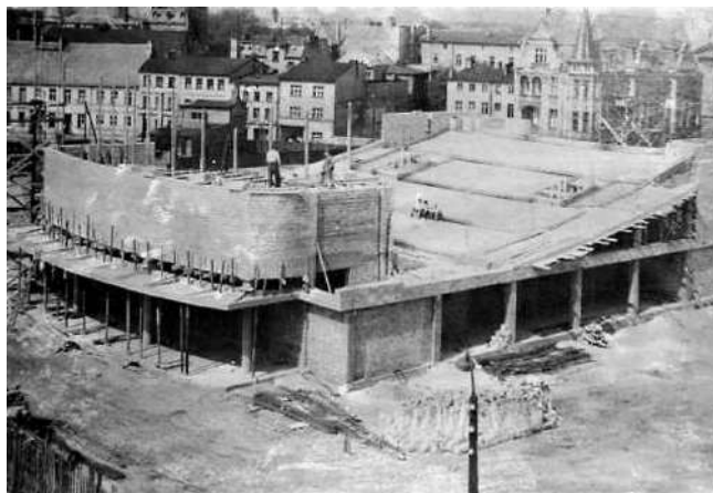
Ryc. 1. Kino podczas budowy – początek lat 60.
