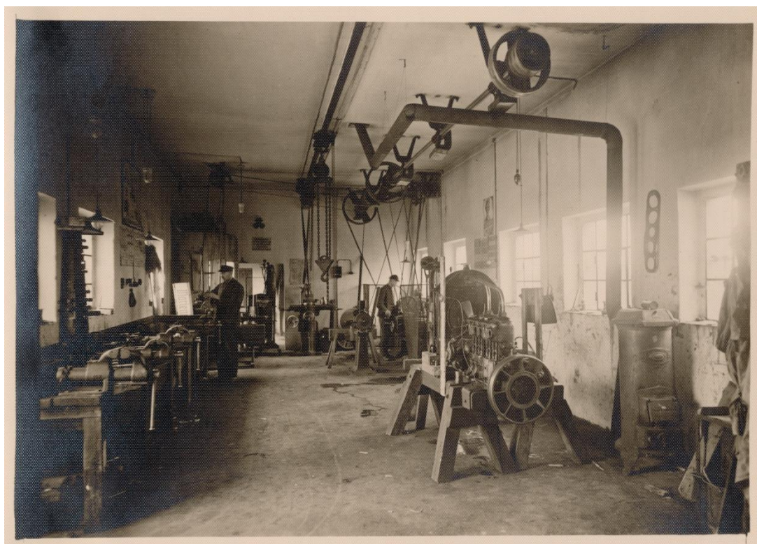
Zdjęcie archiwalne wnętrza pomieszczenia fabryki Alberta Rahn'a. (źródło: Muzeum Zamkowe w Malborku), poz. 6
