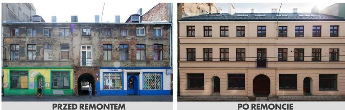
Fot. 3.3 Kamienica przy ul. Wólczańskiej 151 przed i po remoncie źródło: bryła.pl
