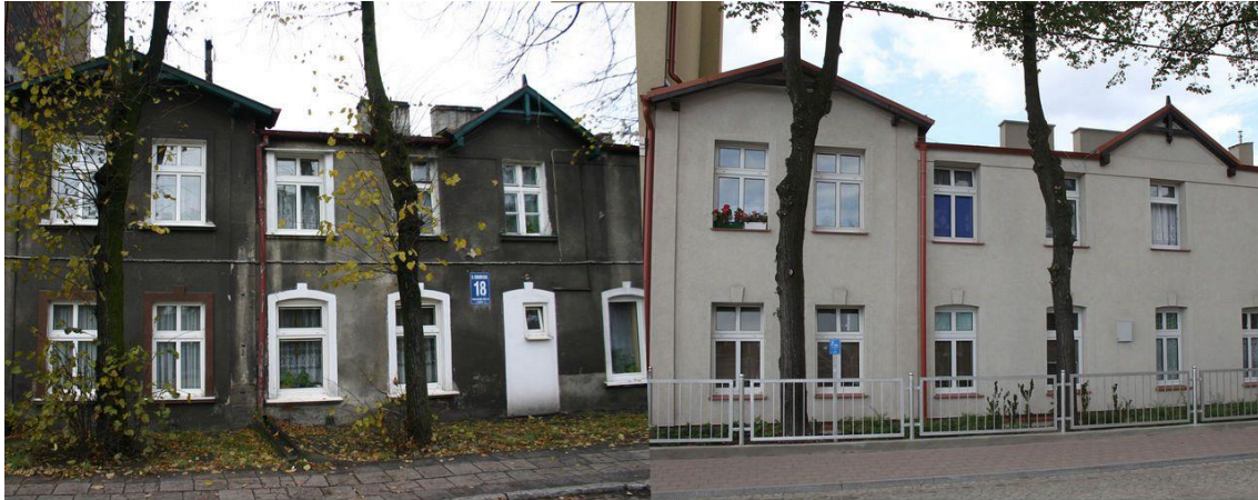
Fot. 3.9 Budynek przy ulicy Starowiejskiej 18 przed i po rewitalizacji źródło: Biuro Rozwoju Gdańska
