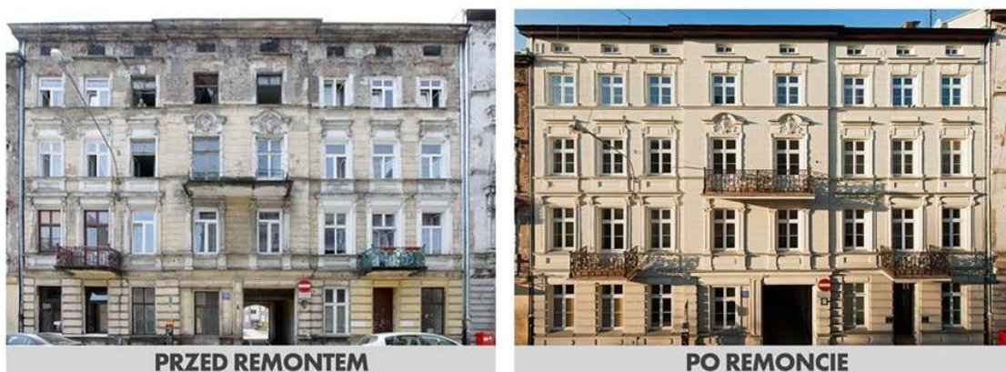
Fot. 3.4 Kamienica przy ul. Legionów 48 przed i po remoncie źródło: bryła.pl
