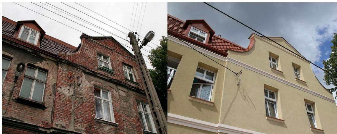
Fot. 3.8 Budynek przy ulicy Starowiejskiej 15/16 przed i po rewitalizacji źródło: Biuro Rozwoju Gdańska
