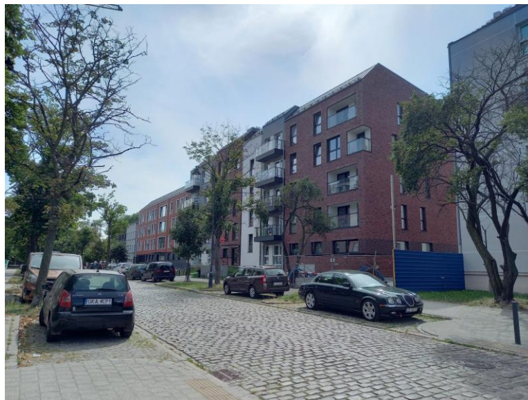
Fot. 4.19 Zabudowa TBS „Motława” przy ul. Kieturakisa źródło: archiwum własne
