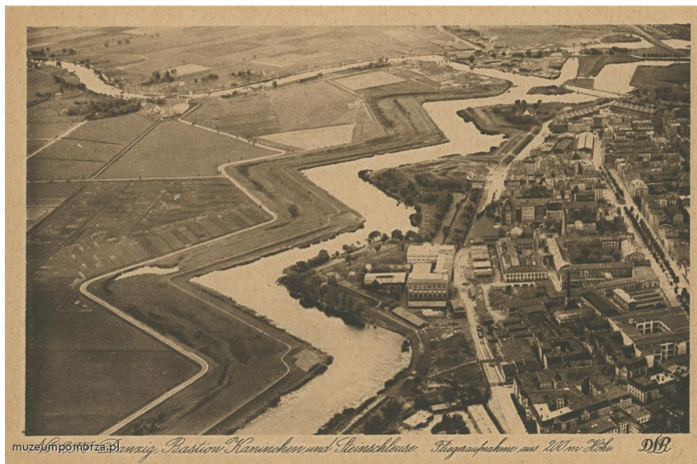
Fot. 4.1 Widok na Dolne Miasto, bastiony i słuzę kamienną z lotu ptaka, ok. 1910 r. źródło: muzeumpomorza.pl
