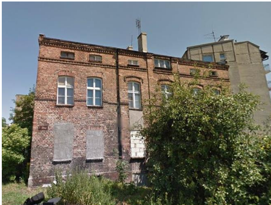
Fot. 4.9 Budynek przy ul. Dobrej 8 przed rewitalizacją, 2011 r. źródło: maps.google.com street view
