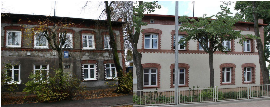
Fot. 3.7 Budynek przy ul. Starowiejskiej 20 przed i po rewitalizacji źródło: Biuro Rozwoju Gdańska
