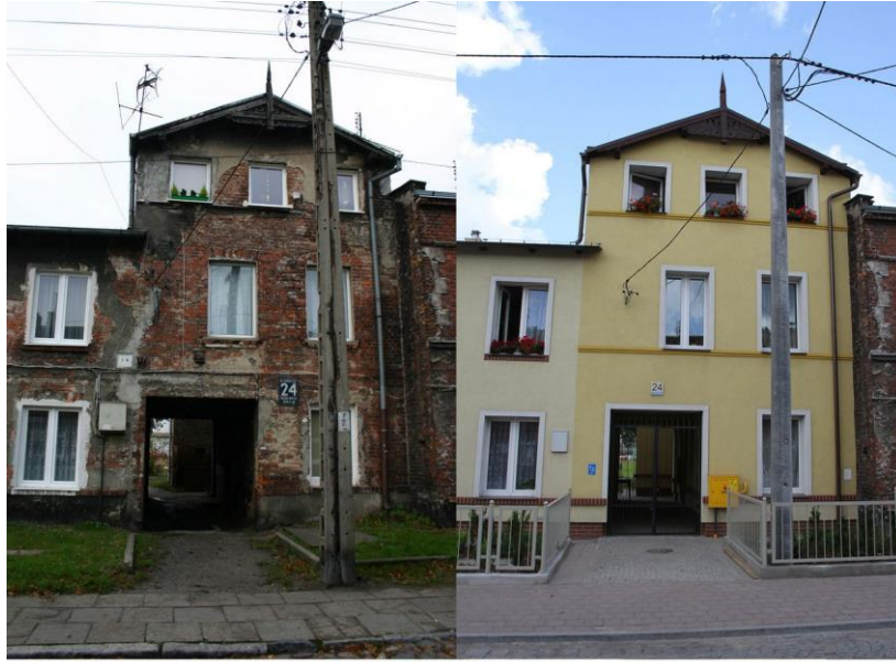
Fot. 3.6 Budynek przy ul. Starowiejskiej 24 przed i po rewitalizacji źródło: Biuro Rozwoju Gdańska
