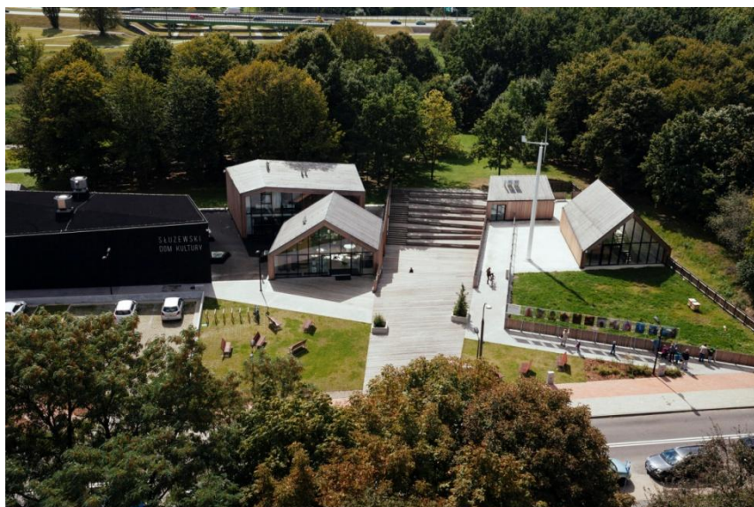
IL. 4. Widok na Służewski Park Kultury
