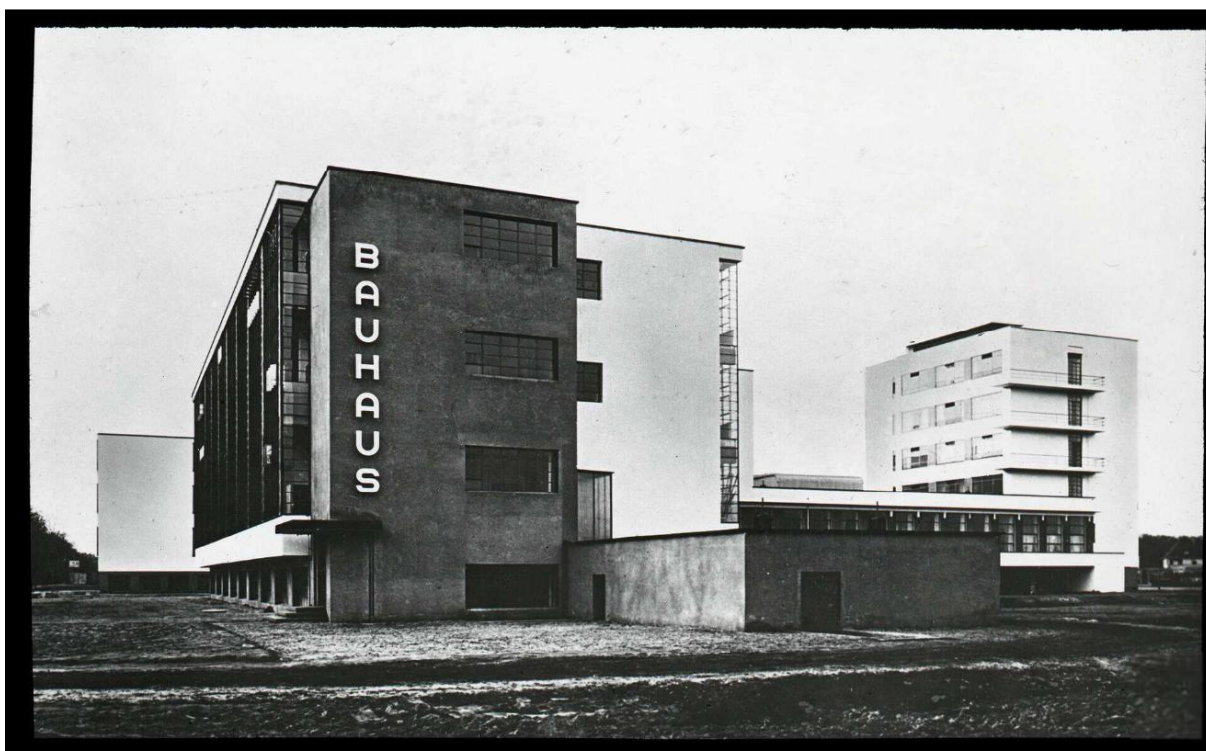
Ryc. 18. Budynek Bauhausu, Dessau (rok 1926)
