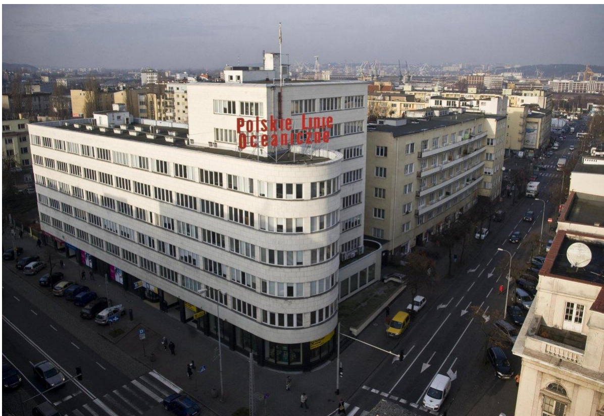
Ryc. 11. Budynek dawnego Biurowiec ZUS, stan obecny (rok 2019)
