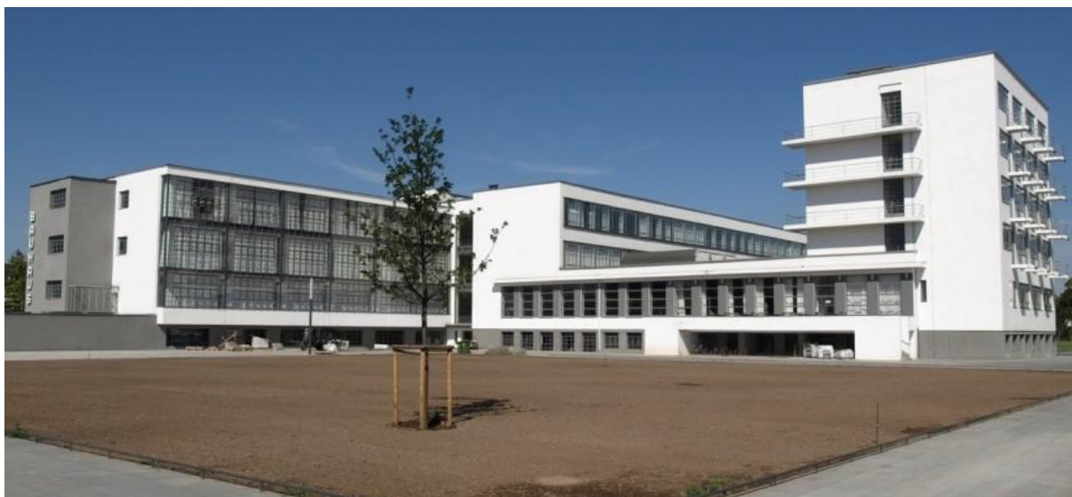
Ryc. 23. Kompleks Bausahus w Dessau obecnie (rok 2015)
