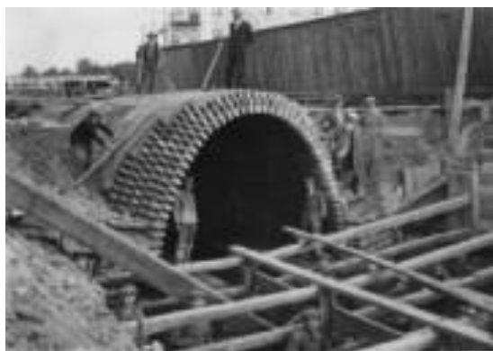
Il.1. Budowa kanałów wodociągowych w Łodzi (źródło: ZWIK łódź, [online: 14 luty 2020], p.30, http://www.zwik.lodz.pl/wgrane_pliki/mini_4o.jpg )
