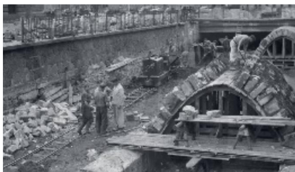
il.12. Budowa kanału Pleißemühlgraben w Lipsku w 1955r. (źródło: Imago-images.de, [online: 13 luty 2020], p.36, https://www.imago-images.de/bild/st/88969493/m/Baustelle,-Kanalisation,-1955,-Plei%C3%9Fem%C3%BChlgraben,-Leipzig,-Sachsen,-DDR,-Deutschl-stockfoto )
