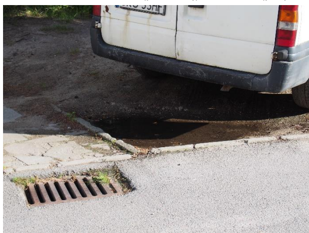
Rys. 5.15, 5.16 Stan techniczny infrastruktury odwodnieniowej na Niedźwiedniku (po lewej), obniżenie w jezdni (po prawej) (fot. Katarzyna Piłatowicz)
