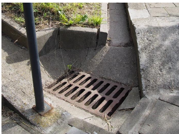
Rys. 5.13, 5.14 Elementy infrastruktury odwodnieniowej na Niedźwiedniku - betonowe rynny starsze (po lewej) i nowsze (po prawej) (fot. Katarzyna Piłatowicz)
