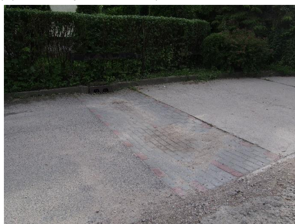
Rys. 5.15, 5.16 Stan techniczny infrastruktury odwodnieniowej na Niedźwiedniku (po lewej), obniżenie w jezdni (po prawej) (fot. Katarzyna Piłatowicz)
