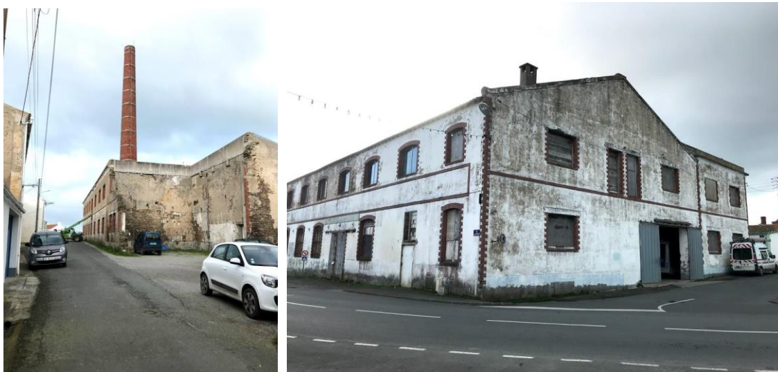
Rys. 21. Stan istniejący - widok od strony południowo - wschodniej oraz zachodniej - elewacji frontowej
