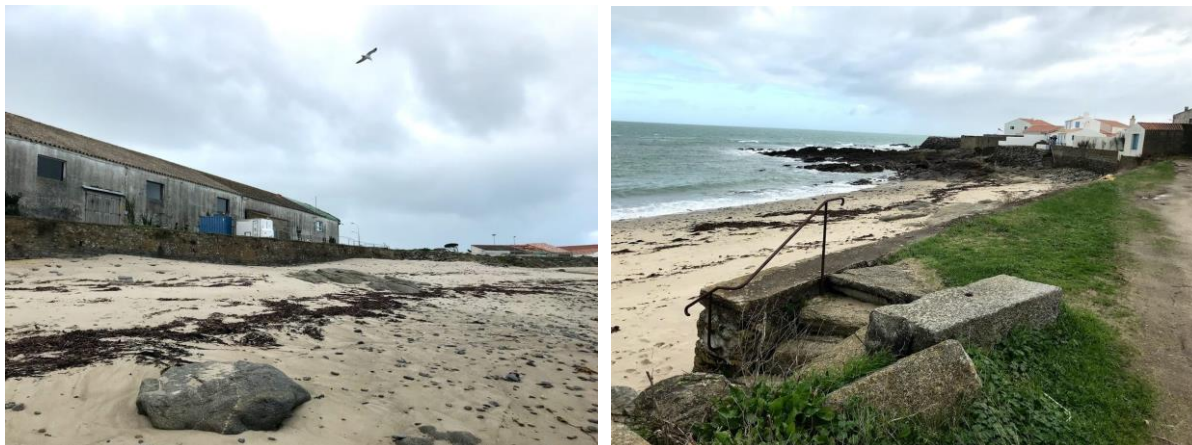
Rys. 26. Stan istniejący - widok od strony oceanu i placu przed budynkiem dawnej filetowni
