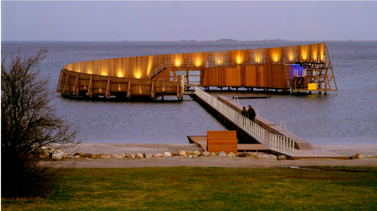
II. 21. Budynek łaźni podświetlony o zmierzchu
