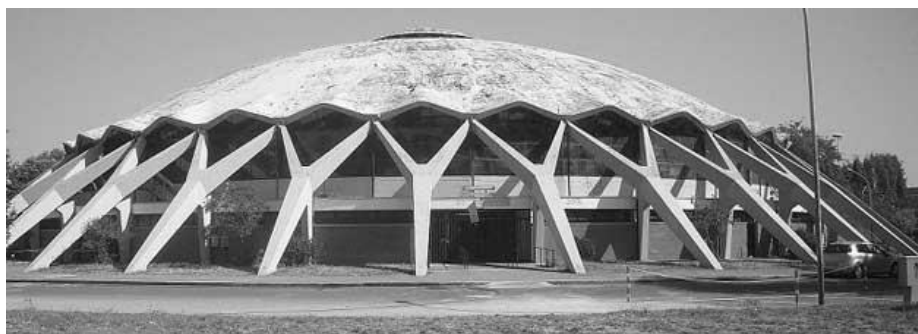
Rys. 11. Widok na elewację Palazzetto dello Sport [40]
