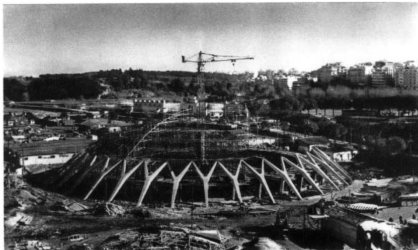
Rys. 8. Budowa Palazzetto dello Sport [30]
