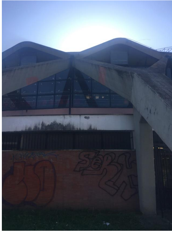
Rys. 24. Widok na zdewastowany fragment elewacji
