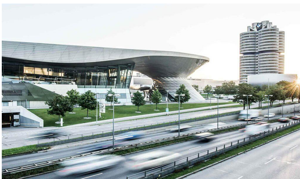
Ilustracja 5. Budynek BMW - Monachium
