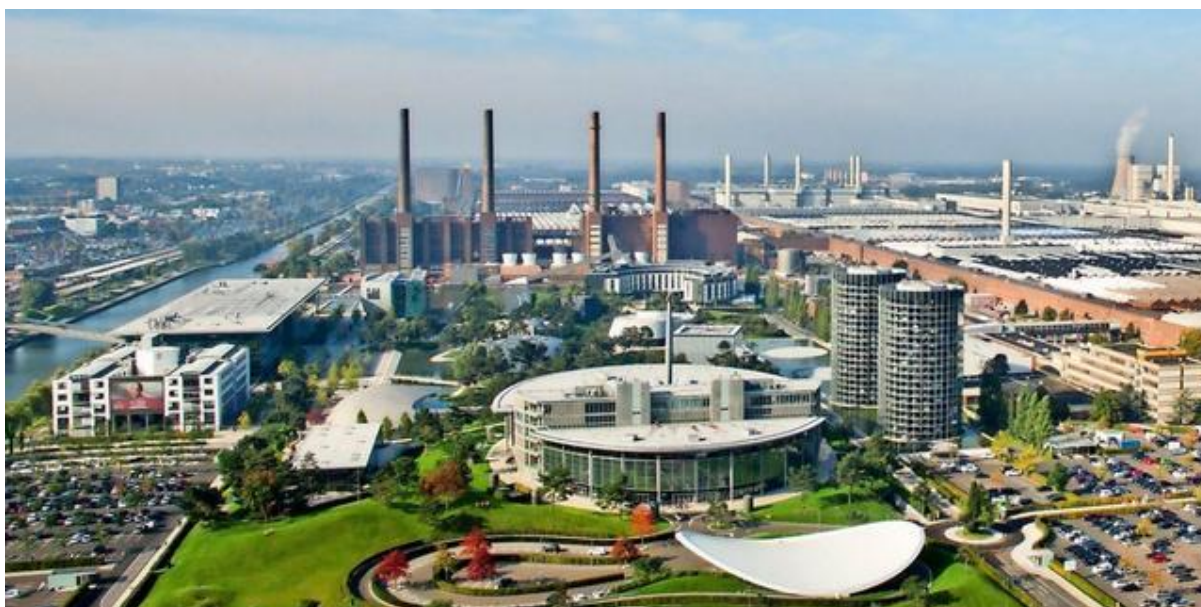
Ilustracja 4. Widok z lotu ptaka kompleksu Autostadt
