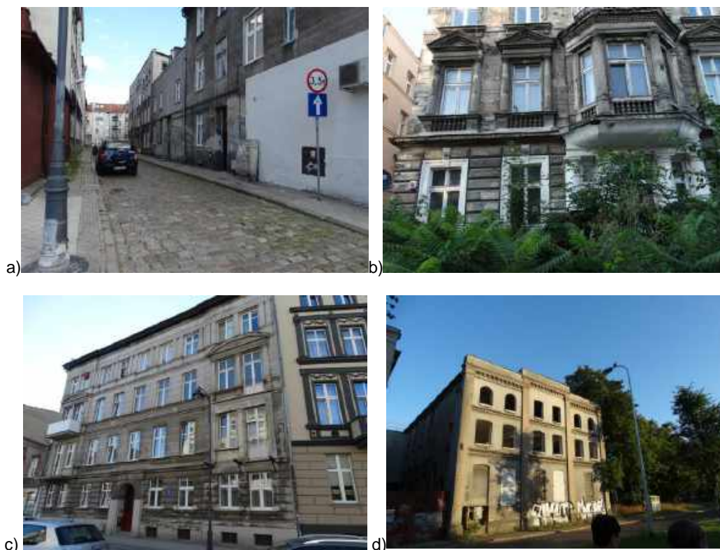
Rys. 11.6. Zaniedbana zabudowa na terenie Dolnego Miasta Źródło: fot. A. Madajczyk
