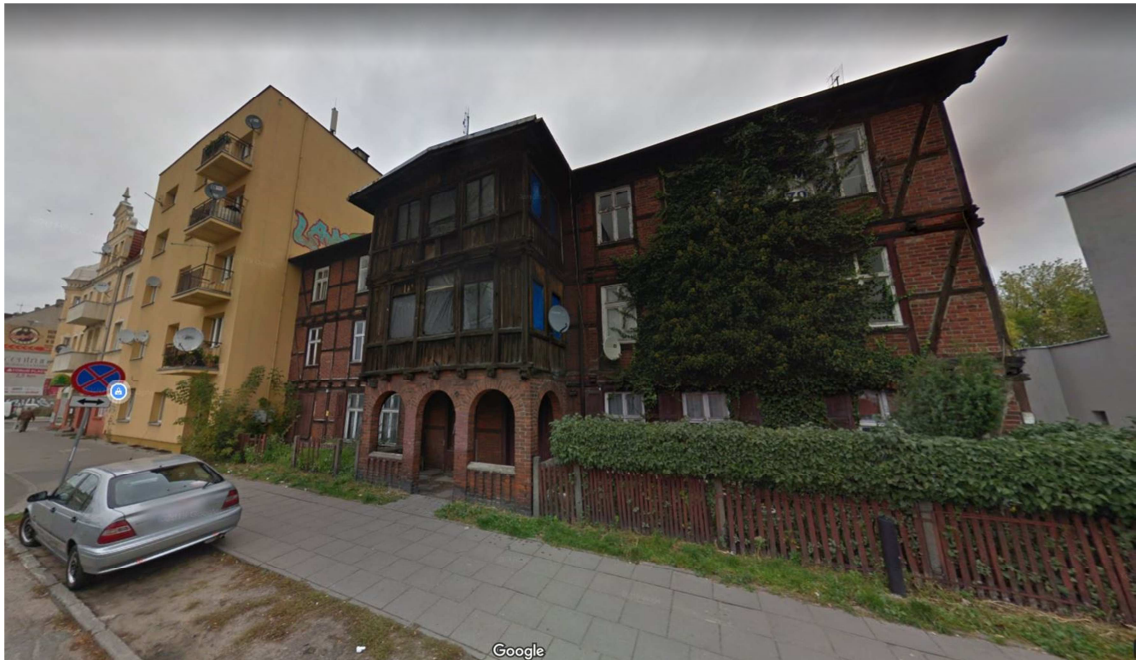
Rys. 3.3. Budynek przeznaczony do rozbiórki pod przyszłą inwestycję mieszkaniówki
