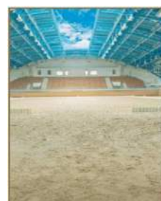
23. Zastosowanie nawierzchni piaskowo gumowej Unirubber w hali sportowej o funkcji ujeżdżalni. źródło: unirubber.com.pl
