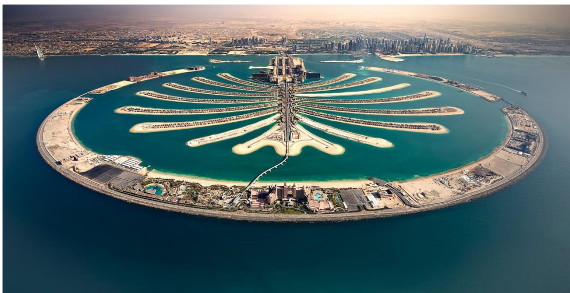
Ryc. 2.11. Palm Jumeirah w trakcie budowy. Źródło: fotografia opublikowana w serwisie internetowym The Pinnacle List (dostęp dnia 26.03.2020), dostępna online pod adresem: https://www.thepinnaclelist.com/articles/uae-real-estate-exploring-7-of-the-most-expensive-luxury-neighbourhoods-in-dubai/attachment/01-palm-jumeirah-island-dubai-united-arab-emirates/
