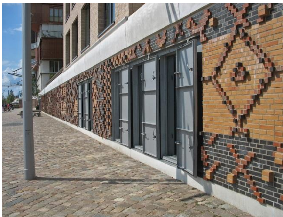
Rysunek 6. Ściany i drzwi odporne na zalewanie (źródło: https://cortescurrents.ca/ ; dostęp: 31.07.2020 r.)
