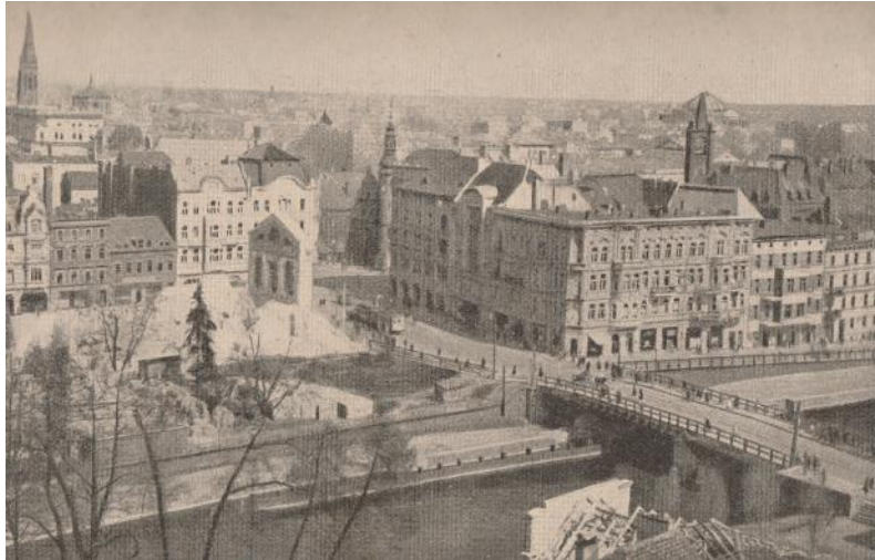
Rys. 3.2. Widok na zniszczony Teatr Miejski
