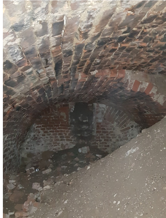
ryc. 113 Zamurowane przejście, strona północna, fot. O. Jaworska, 2020 r.
