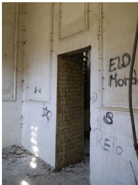
ryc. 86 Parter. Tynki z lat 80., fot. O. Jaworska, 2020 r.
