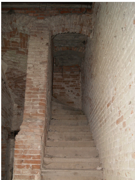
ryc. 87 Klatka schodowa na I piętro, fot. O. Jaworska, 2020 r.
