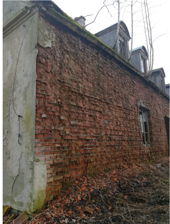
ryc. 97 Narożnik północno wschodni. Stan cegły i tynku, fot. O. Jaworska, 2020 r.
