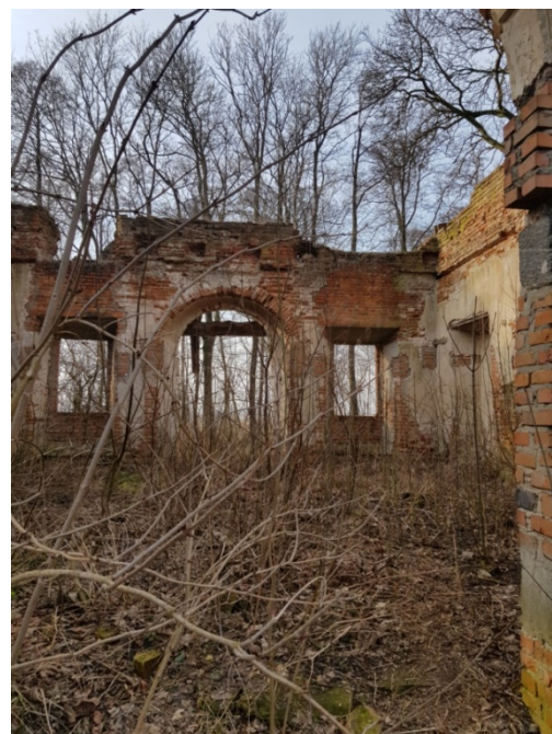
ryc. 105 Widok na narożnik północno zachodni, fot. O. Jaworska, 2020 r.
