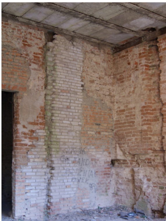
ryc. 83 Parter. Uzupełnienia z różnych okresów i wykute szachty, fot. O. Jaworska, 2020 r.
