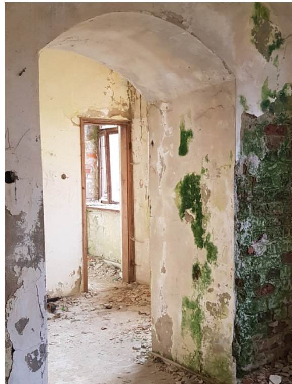
ryc. 99 Wyjście z części autentycznych murów do części dobudowanej, fot. O. Jaworska, 2020 r.
