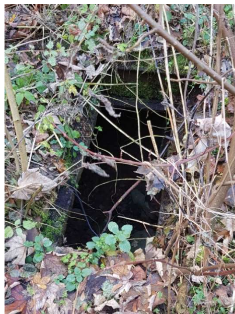
ryc. 107 Otwór w stropie parteru, fot. O. Jaworska, 2020 r.
