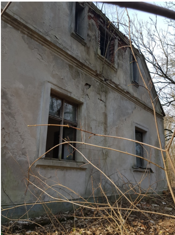
ryc. 94 Elewacja szczytowa, wschodnia, fot. O. Jaworska, 2020r.
