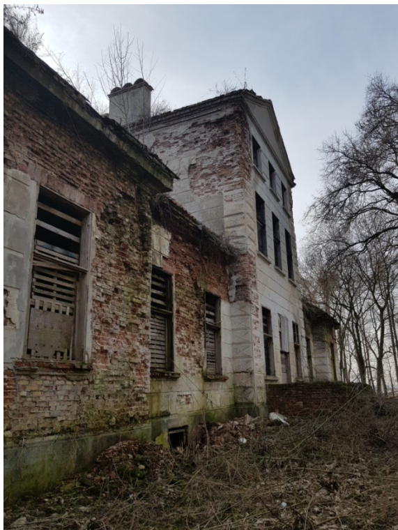
ryc. 75 Fasada ogrodowa, fot. O. Jaworska, 2020 r.
