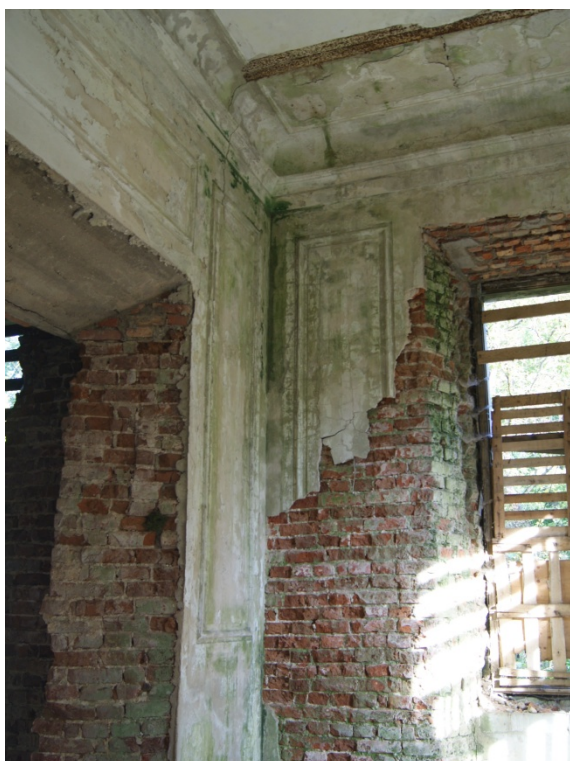
ryc. 85 Parter. Pozostałości oryginalnych tynków, fot. O. Jaworska, 2020 r.
