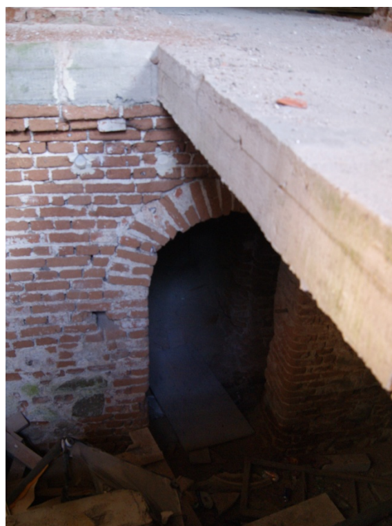
ryc. 82 Przejście w piwnicy z poziomu parteru, fot. O. Jaworska, 2020 r.
