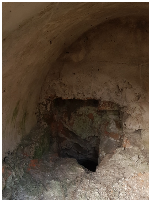
ryc. 80 Prawdopodobnie zamurowane okno w elewacji na poziomie piwnicy, fot. O. Jaworska, 2020 r.
