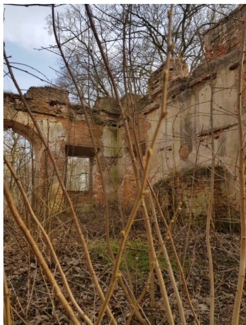
ryc. 104 Widok na narożnik południowo wschodni, fot. O. Jaworska, 2020 r.
