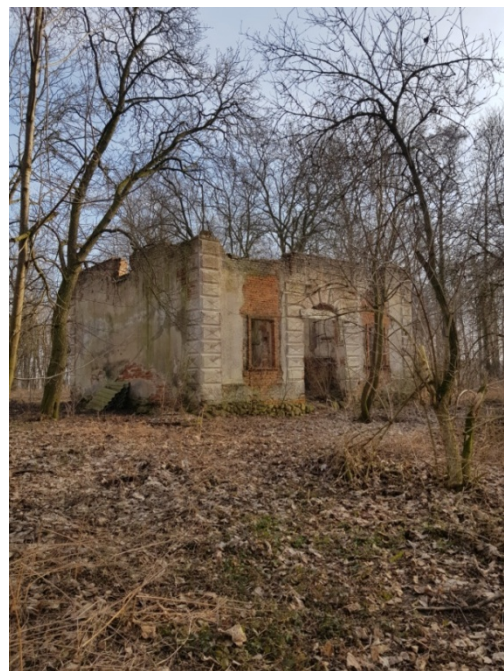
ryc. 103 Widok na narożnik północno zachodni, fot. O. Jaworska, 2020 r.
