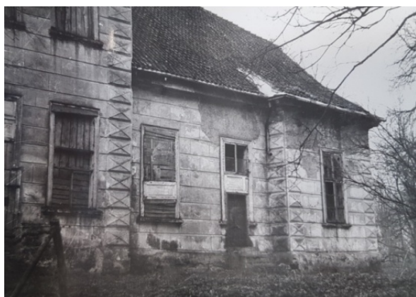
ryc. 25 Pałac - elewacja ogrodowa, fot. H. Orzechowska, Zbiory Wojewódzkiego konserwatora Zabytków oddział w Ciechanowie, 1972 r.
