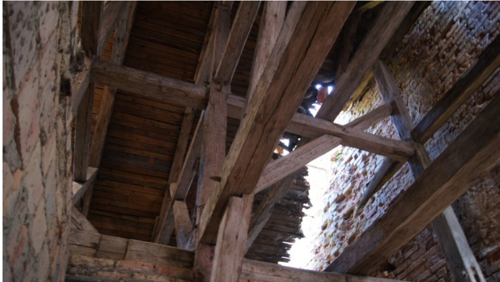
ryc. 91 Więźba dachowa nad poziomem piętra I, widok na ścianę ryzalitu środkowego, fot. O. Jaworska, 2020 r.
