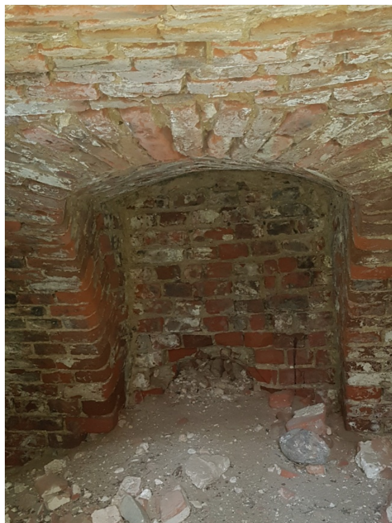
ryc. 111 Zamurowane przejście na przeciwko wejścia, fot. O. Jaworska, 2020 r.
