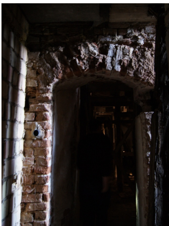
ryc. 89 Piętro I. Przejście do ryzalitu środkowego, fot. O. Jaworska, 2020 r.
