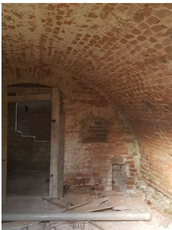
ryc. 81 Sklepienie kolebkowe skrajnej, wschodniej części piwnicy, fot. O. Jaworska, 2020 r.
