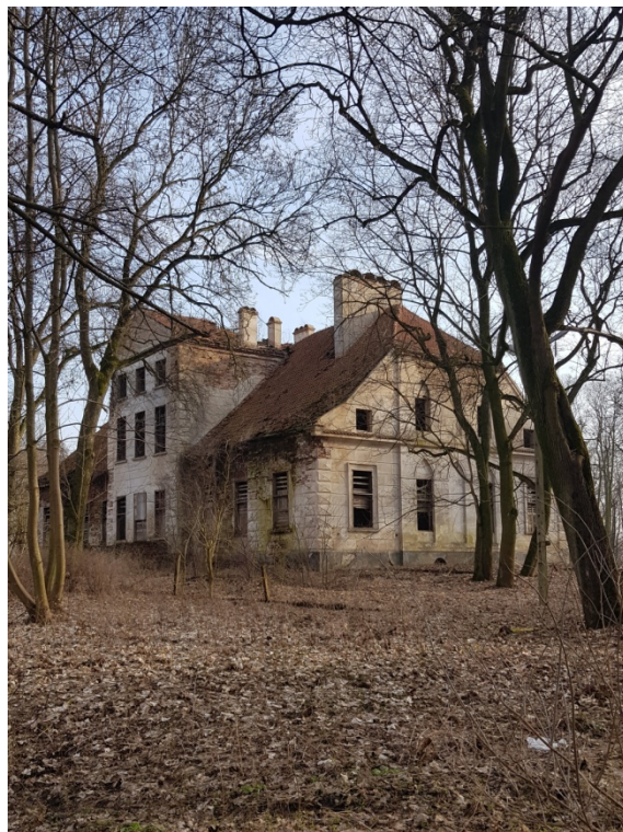
ryc. 76 Narożnik od strony północno zachodniej, fot. O. Jaworska, 2020 r.
