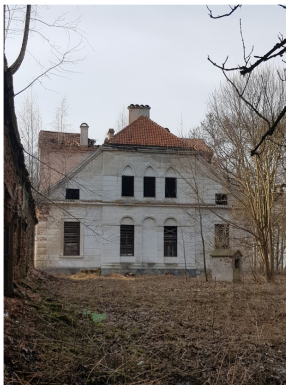
ryc. 74 Elewacja wschodnia, fot. O. Jaworska, 2020 r.
