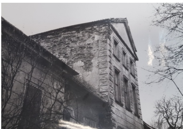
ryc. 24 Pałac - elewacja ogrodowa, fot. H. Orzechowska, Zbiory Wojewódzkiego konserwatora Zabytków oddział w Ciechanowie, 1972 r.
