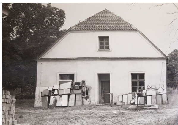
ryc. 41 Oficyna, elewacja szczytowa, fot. R. Merchel, PKZ-Olsztyn, 1988 r.
