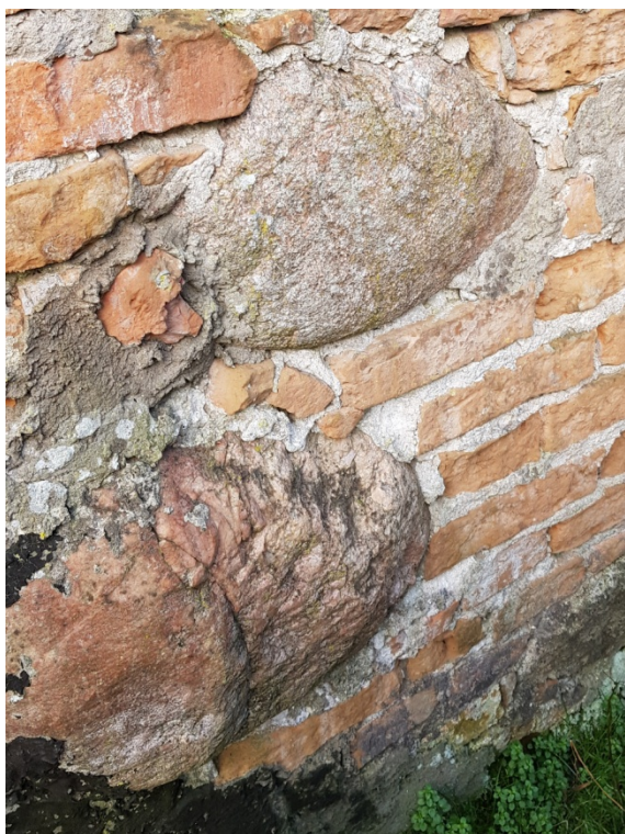
ryc. 79 Kamienne uzupełnienia w fundamencie piwnicy, fot. O. Jaworska, 2020 r.
