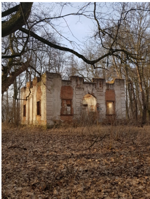
ryc. 102 Widok na narożnik południowo wschodni, fot. O. Jaworska, 2020 r.
