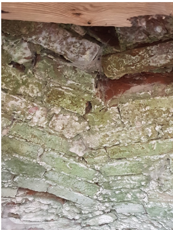
ryc. 110 Sklepienie klatki schodowej, fot. O. Jaworska, 2020 r.
