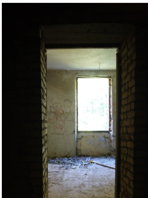
ryc. 90 Piętro I. Otwór w nowej ścianie, widok na okno w ścianie szczytowej, fot. O. Jaworska, 2020 r.
