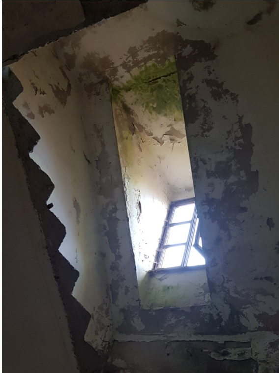
ryc. 100 Widok z klatki schodowej na I piętro, fot. O. Jaworska, 2020 r.
