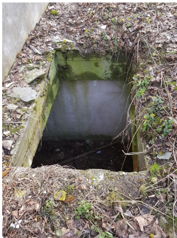
ryc. 78 Właz do nowej części piwnicy, fot. O. Jaworska, 2020 r.
