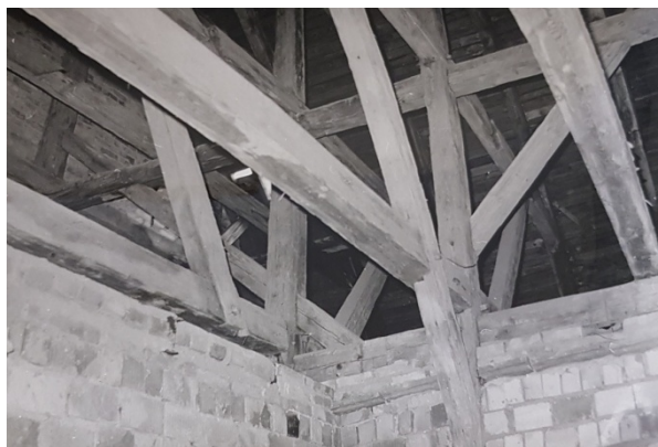
ryc. 37 Pałac, fragment więźby dachowej, fot. R. Merchel, PKZ-Olsztyn, 1988 r.
