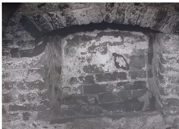
ryc. 35 Pałac, zamurowane okno w piwnicy, fot. R. Merchel, PKZ-Olsztyn, 1988 r.
