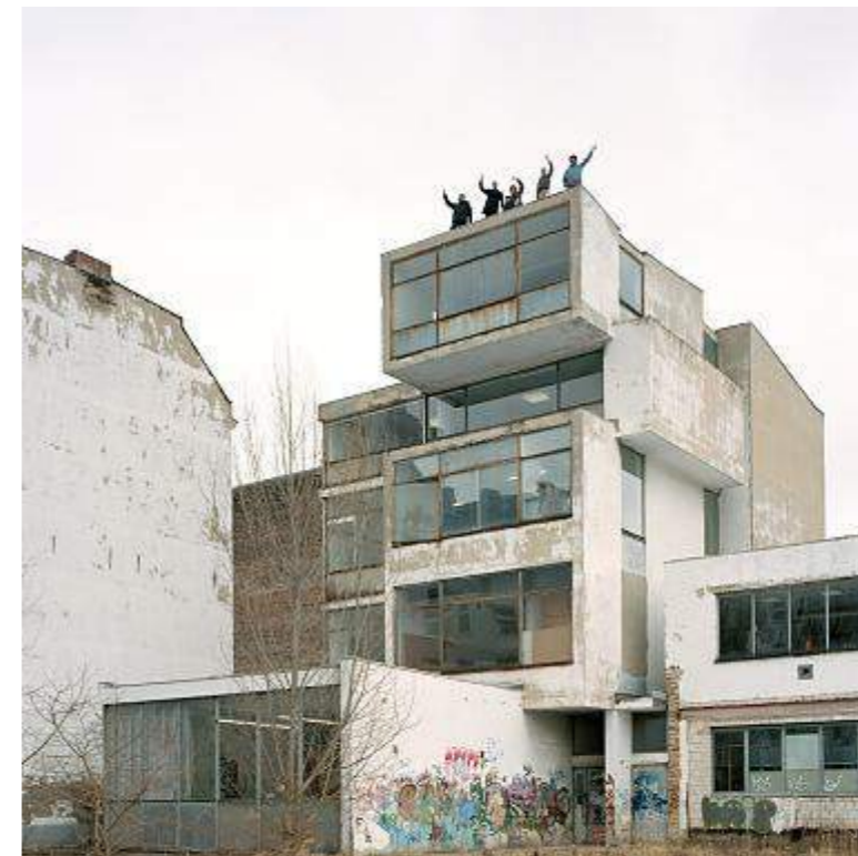
Rys 1.3.1 Budynek ExRotaprint – dobudowa ( https://www.exrotaprint.de/en/ , dostęp: 09.2019)
