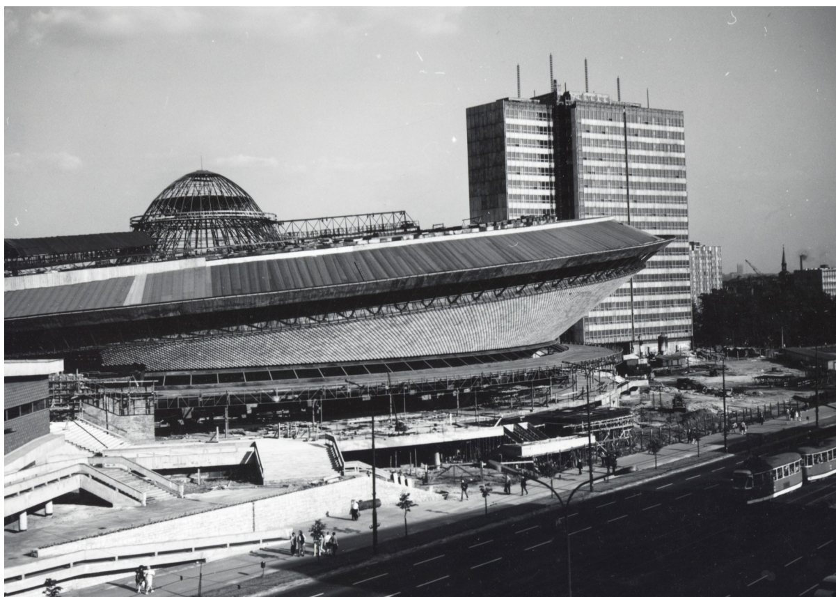
Hala widowiskowo-sportowa Spodek, Katowice. [online: 07.02.2020], https://www.historiaposzukaj.pl/assets/media/Wiedza/Architektura/has.jpg
