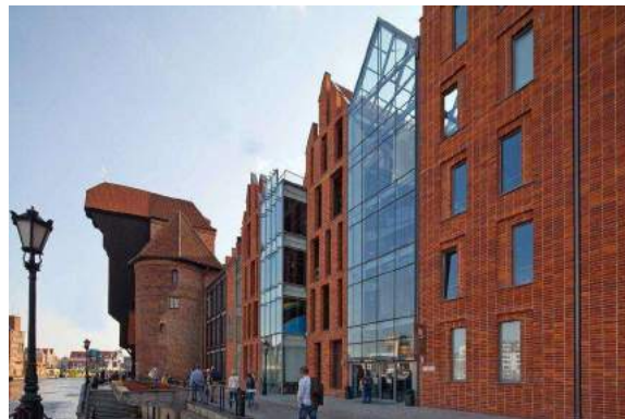
Rys.8. Budynek Ośrodka Kultury Morskiej-Gdańsk. Podziały budynku oraz kształt dachu przywołują gdańskie kamienice nowożytne, źródło: https://visiton.pl/miejsca-atrakcje-zabytki/muzea/ad/6788-narodowe-muzeum-morskie-w-gdansk-u-osrodek-kultury-morskiej.html , online: 20.09.20
