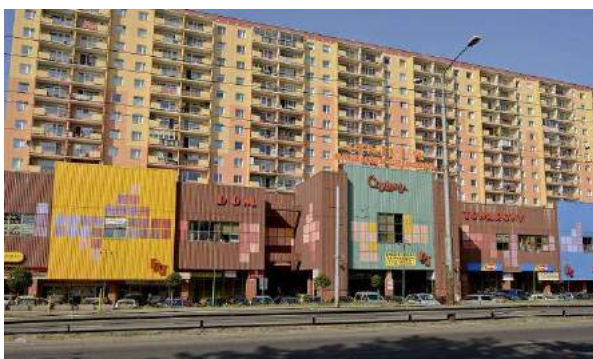
Rys.15. Dom towarowy Chylonia- Gdynia. Budynek przed renowacją. Widoczne podziały budynku, poszczególne wykusze podkreślone zostały odmiennym kolorem. źródło: https://dom.trojmiasto.pl/Dom-Towarowy-Chylonia-zmienil-kolor-elewacji-n118335.html?strona=2&id_zdjecia=332391&type=2#fb_id:p0:332391,pozycja:0 , online: 20.09.20.
