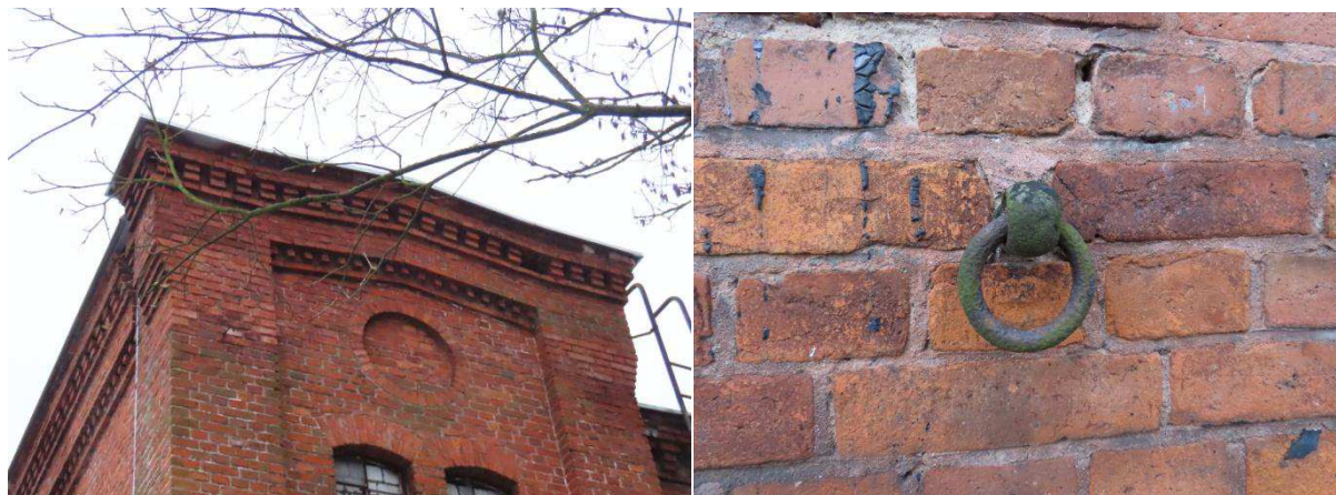
Rys. 6, 7. Zachowane historyczne detale architektoniczne, budynek stajni północnych Koszarów Dragonów w Olsztynie. Po lewej ozdobne zwieńczenie ryzalitu na końcu budynku, po prawej jeden z żeliwnych koniowiązów umieszczonych na elewacji budynku od strony dziedzińca.
