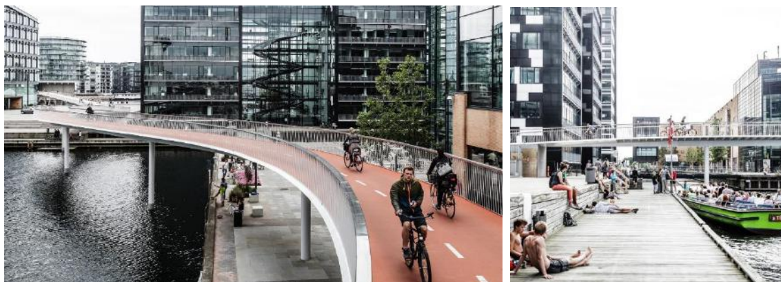
Fig. 3,4 Most rowerowy w okolicy centrum handlowego Fisketorvet, w Kopenhadze nazywany Wężem Rowerowym. Dissing+Weitling 2014
