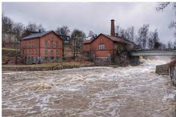
4. MUZEUM TECHNIKI Muzeum znajduje się nad rzeką Vantaa. Budynek muzeum zostały zbudowane jako pierwsze wodociągi w Finlandii prawie 150 lat temu.
