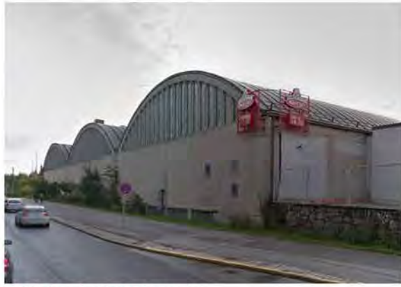
1. BUDYNEK PRZEMYSŁOWY Mieści się w nim warszta samochodowy i autobusowy oraz tor gokartowy.
