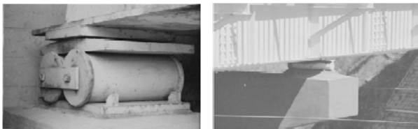
Podpora przegubowo-przesuwna belki żelbetowej
