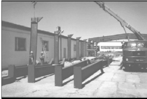
Szczegół podparcia ramy za pomocą utwierdzenia
