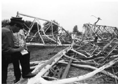
Najwyższym masztem radiowym na świecie był maszt w Gąbinie. Miał wysokość 646,38 metrów. Wybudowany w 1974 roku służył do nadawania programu I Polskiego Radia. Program był słyszalny w całej Europie, Afryce Północnej i dużej części Azji (czasami w Ameryce Północnej). Maszt runął 8 sierpnia 1991 na skutek źle prowadzonych prac konserwatorskich (nie został odbudowany).
